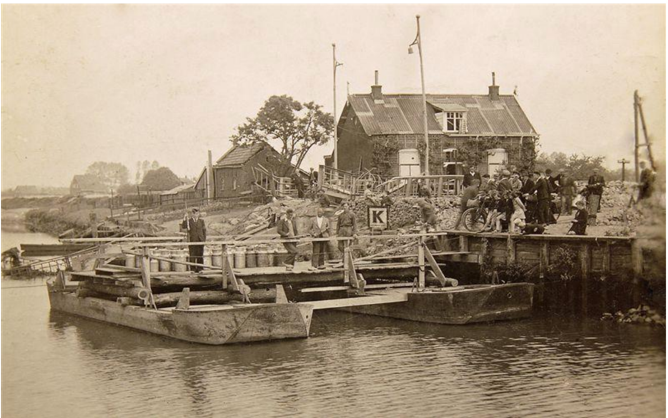
Deze foto betreft een pontonbrug die ingezet werd nadat de brug over de Oude IJssel eruit geschoten was door de Duitsers. Op de achtergrond zie je de vernielde brug. De foto is genomen in Terborg in 1945.
